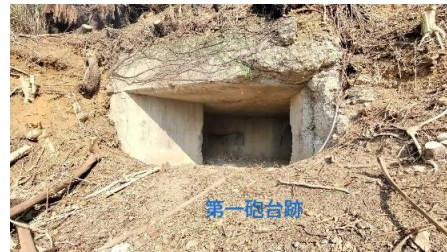
第一砲台跡 コンクリート構造物
